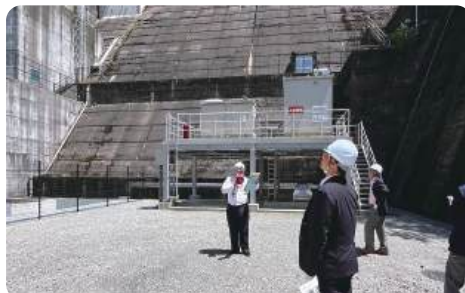
西日本豪雨災害で主要機器が全損、令和5年から運転を再開した脇川発電所にて。災害に強いインフラ作りを推進します！
