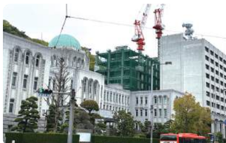
建設が進む県庁第二別館。スタートアップ企業支援をはじめとする官民共創拠点として活躍します！
