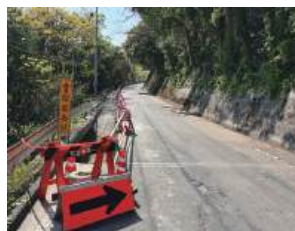
地元要望の多かった伊方町三崎の県道陥没部分の改修工事が始まりました。安全安心を守るためのインフラ整備に全力を尽くします！
